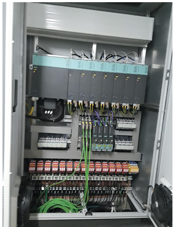
РИС. 2. ▼ В верхней части этого корпуса системы координированных приводов Sinamics S120 установлены линейный модуль и модули двигателей, которые обеспечивают управление колесом обозрения ICON Orlando
