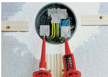
Проверка напряжения в клеммах для распределительных коробок
